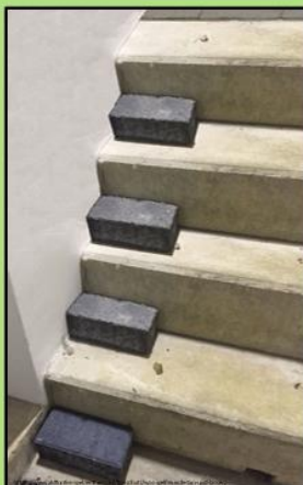
Ziegelsteine zur Verringerung der Stufenhöhe
